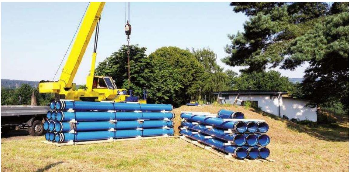
Abbildung 12.20: Beispiel Filterrohre mit Hagulitbeschichtung
