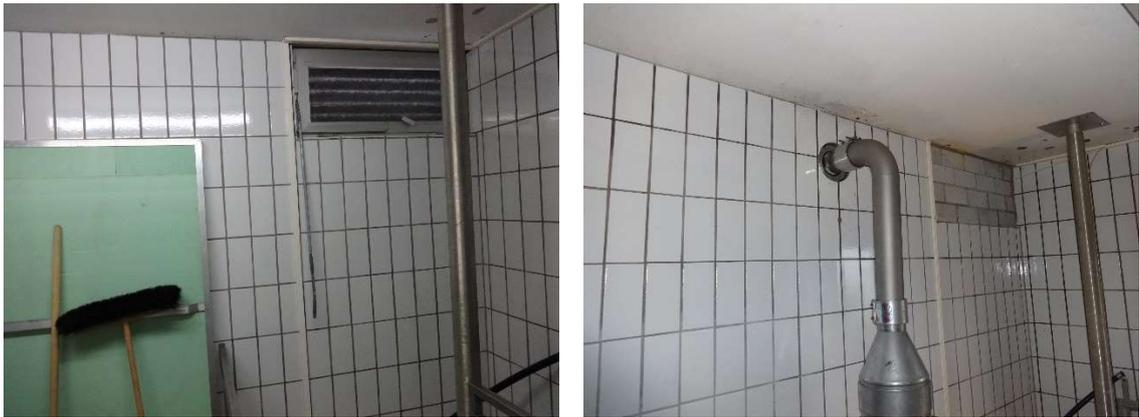
Abbildung 12.3: Be- und Entlüftung vor und nach Umbau (Fliesenbelag fehlt noch)
