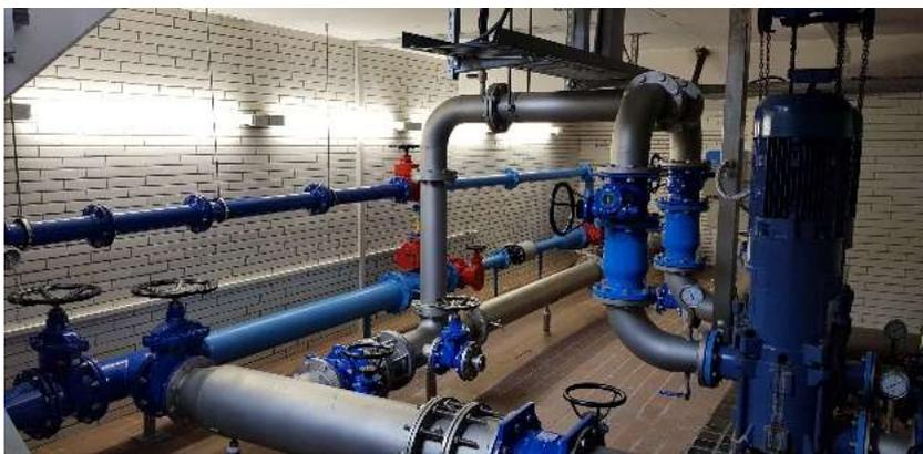
Abbildung 12.57: Rohrkeller mit druckseitiger Verrohrung
