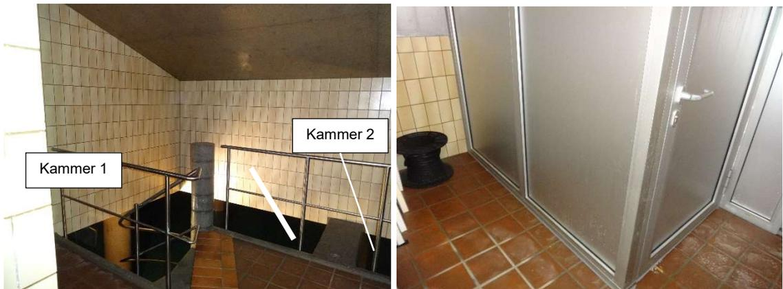
Abbildung 12.4: Offene Kammern und nach Umbau mit Leichtmetallebtrennung
