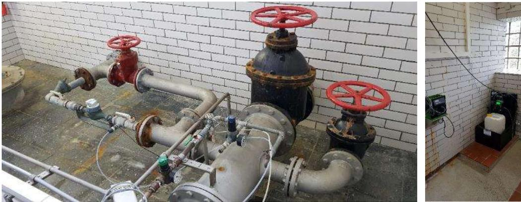
Abbildung 12.32: Verrohrung mit Korrosion und Chlordosieranlage
