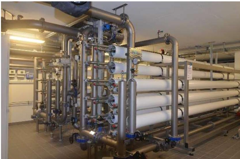
Abbildung 12.61: Niederdruck-Umkehrosroseanlage
