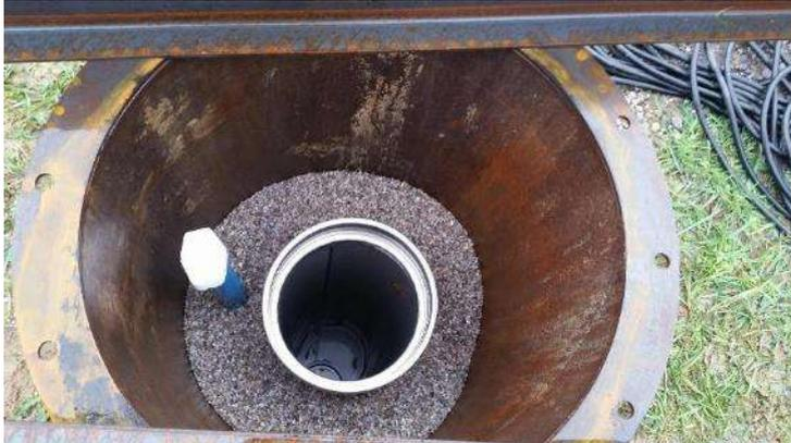
Abbildung 12.36: Blick auf Filterrohr beim Brunnenneubau
