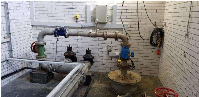
Abbildung 12.30: Brunnenkopf mit Verrohrung
