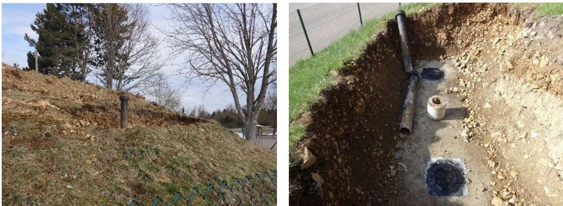
Abbildung 12.2: Beispiel für Dunsthüte und rückgebaute Dunsthüte Kammerbelüftung
