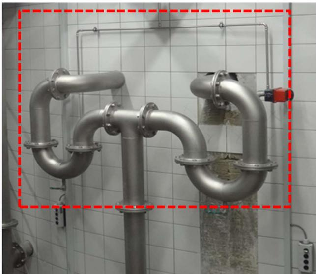
Abbildung 12.6: Überlauf mit Siphon für zwei Kammern inkl. Nachspeisung
